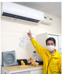
エアコンチェック
